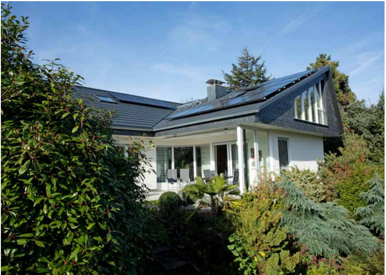
Über 29 Jahre hat sich die Dachdämmung auf diesem Eigenheim bereits bewährt – und kann dank Verstärkung weiter genutzt werden.
