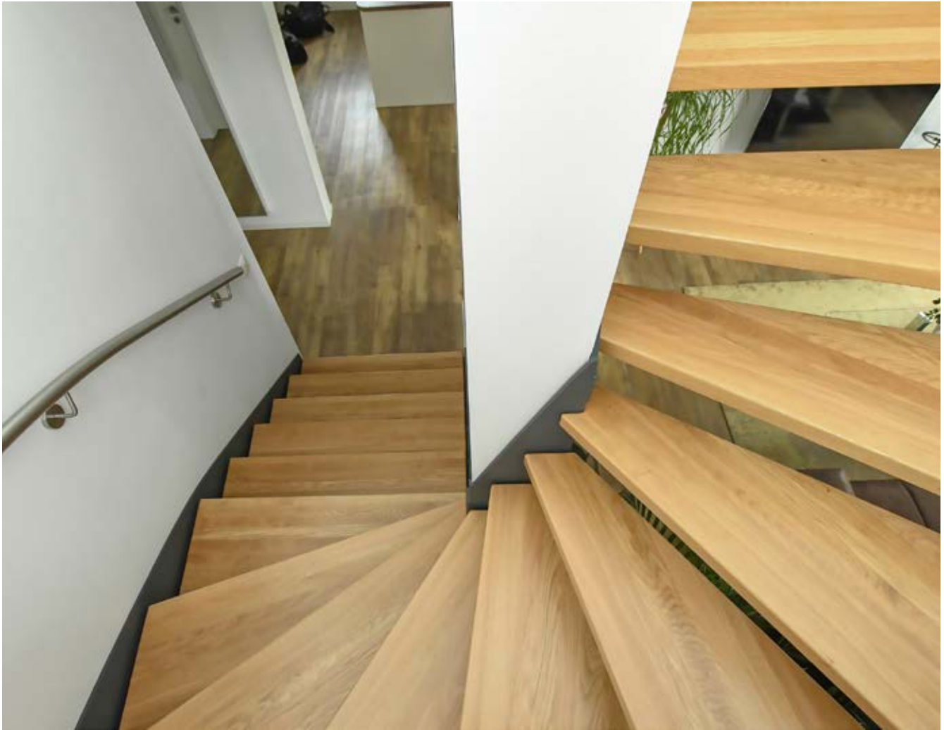
Die Trittstufen aus Eichenholz wurden mit Klarlack versiegelt und sind besonders pflegeleicht und bequem begehbar.
